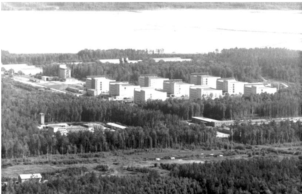
Вид корпусов Рефтинской бройлерной фабрики с дымовой трубы Рефтинской ГРЭС. На заднем плане виден второй золоотвал.
