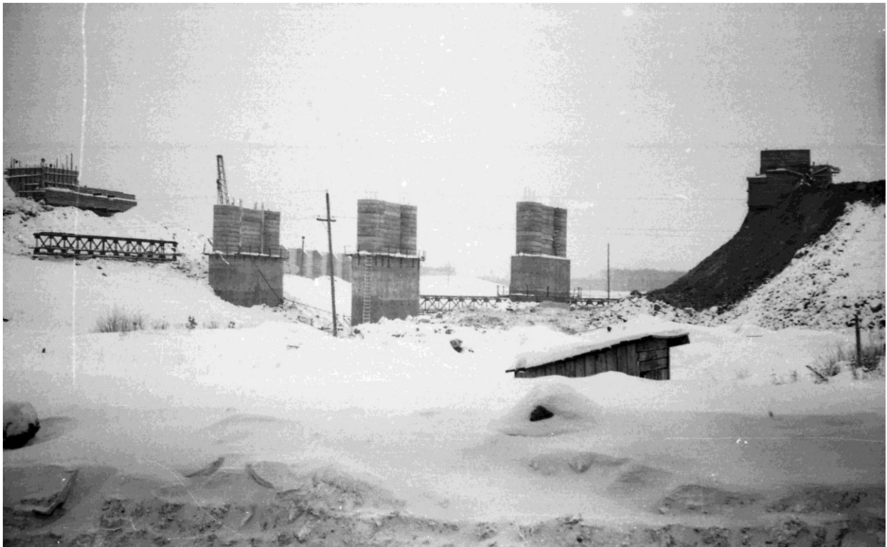
Строительство моста через Рефт, до 1968г. фото Рыжакова А.И.
