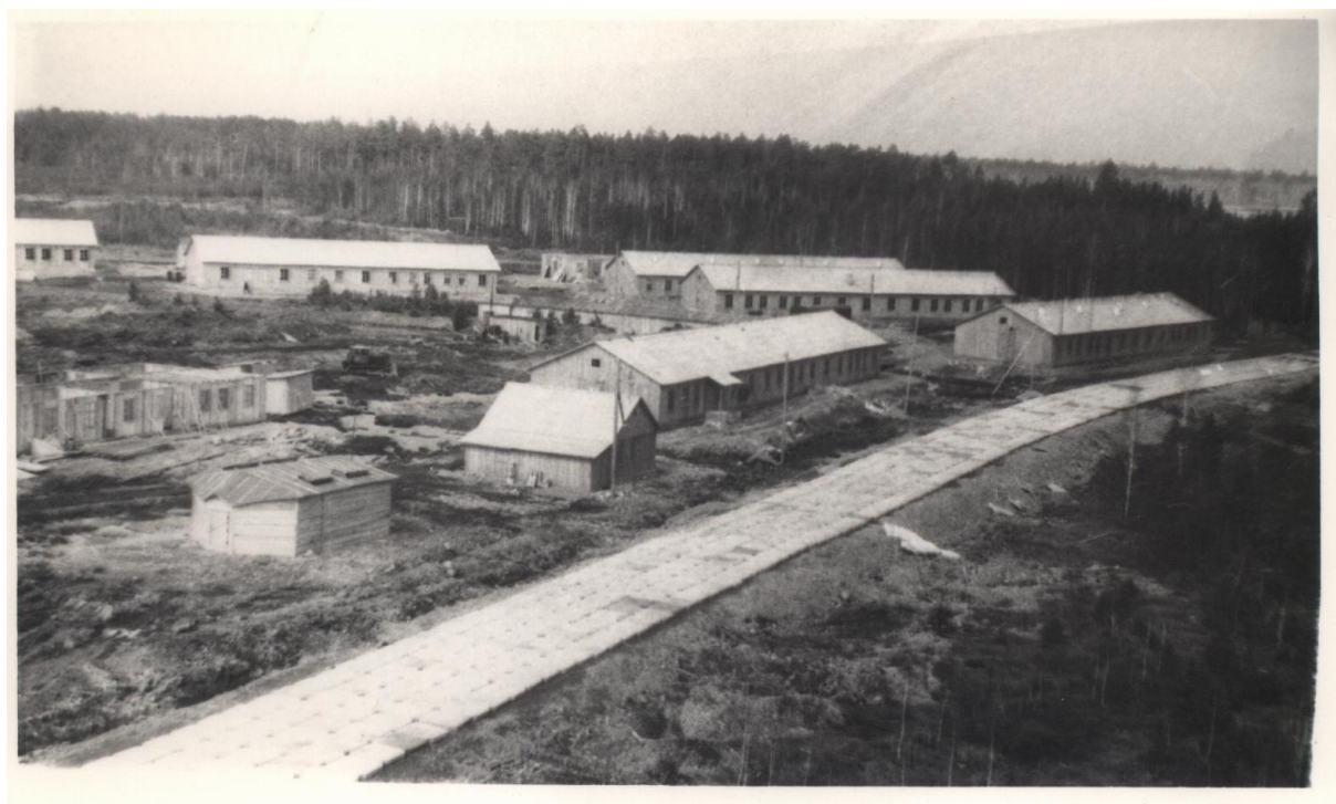
Перевалочная база строительства Рефтинской ГРЭС в г. Асбесте, т.н. посёлок Опушка. 1964г.
