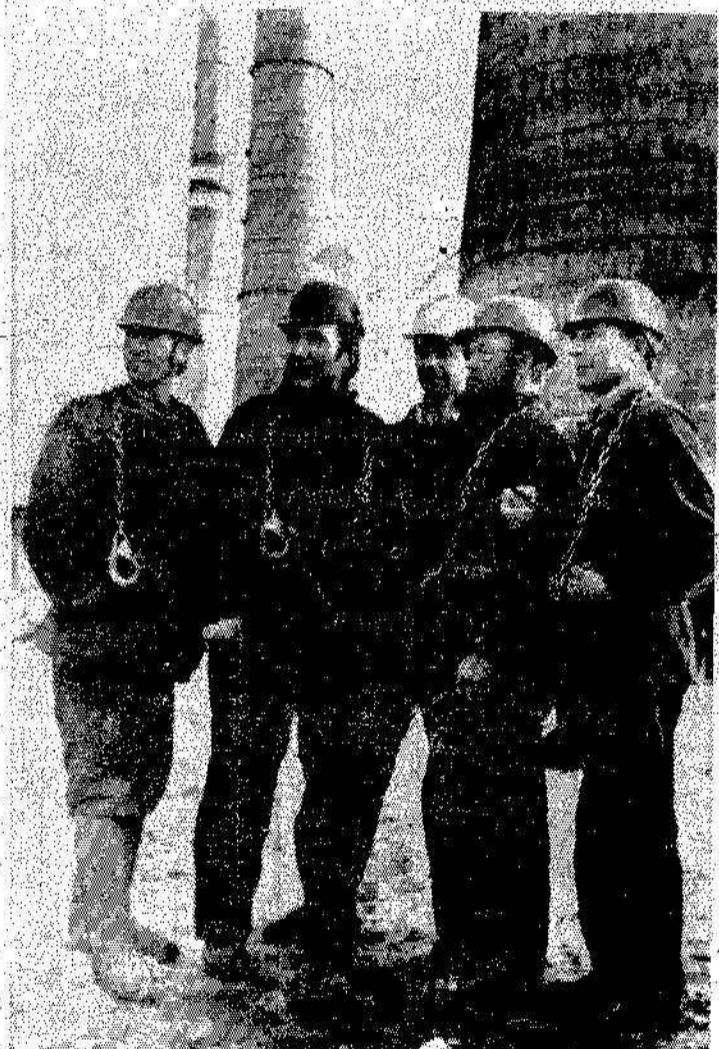
Трубоклады поставили перед собой задачу — в марте достичь высоты дымовой трубы 290 метров. На бетонировании ствола трубы хорошо трудится бригада А. Н. Габдрахимова. Успешно справляясь с заданием, она добивается и хорошего качества. НА СНИМКЕ: трубоклады И. И. ОСИПКИ, А. Н. ГАБДРАХИМОВ, А. А. КАТМАКОВ, А. Е. МАРКОВ, Л. Г. ЧЕХОМОВ. Фото С. ШВЕЦОВА.
