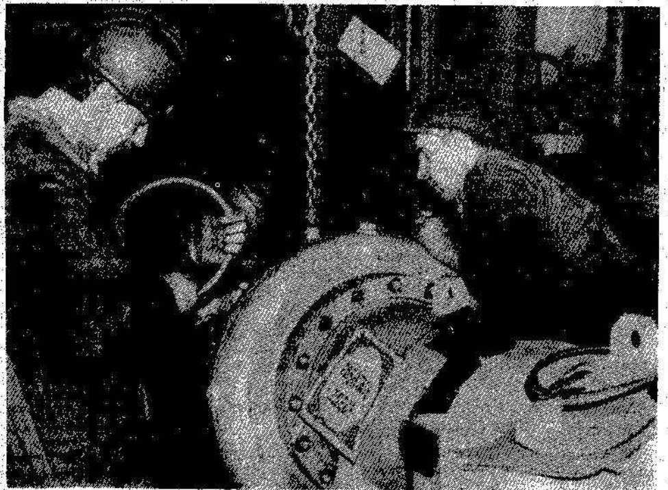
На снимке: Субботник. Идет ремонт насоса системы охлаждения генератора блока № 8.
