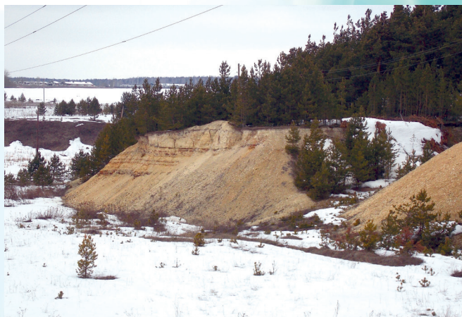
Окраина посёлка Красногвардейского. Выход опоки на поверхность
