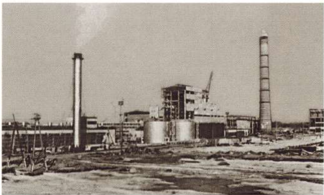
Здание пусковой котельной. Сооружение главного корпуса энергоблоков 300 тыс. кВт. 1969 год
