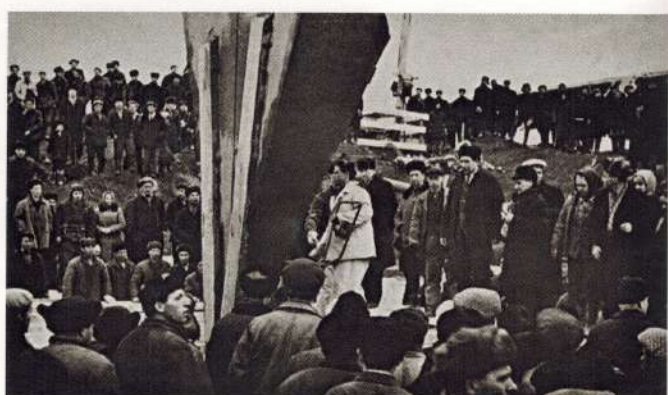
Закладка первого кубометра бетона в фундаменте главного корпуса ГРЭС. В первую ось ряда «б» была заложена бронзовая капсула с обращением к потомкам. Принимала первый бетон бригада В. А. Авдюкова. 25 марта 1967 года
