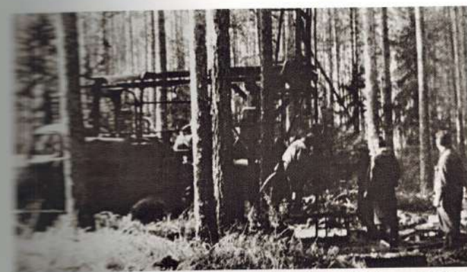
Выскапыватели теплоэлектропроекта на площадке будущей Рефтинской ГРЭС
