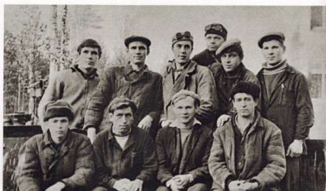
Бригада УСЭМ производила монтаж каркаса главного корпуса
