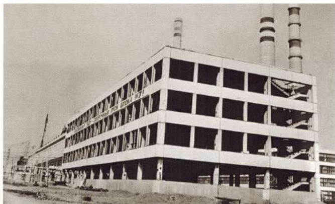
Каркас здания административно-бытового корпуса
