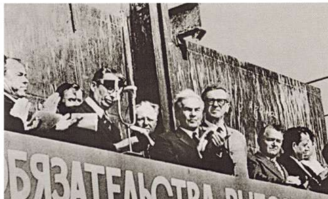
На митинге, посвященном досрочному пуску в эксплуатацию энергоблока мощностью 300 тыс. кВт ст. № 6. Слева направо: секретарь парткома ГРЭС В. А. Урбанович, директор ГРЭС Ю. В. Иванов, бригадир монтажников В. Ф. Пчелин, начальник строительства И. В. Вольфсон, зам. директора ГРЭС А. В. Александров, главный инженер Уралэнерго В. Д. Ефимов, зам. начальника управления строительства А. С. Емельянов. 31 мая 1975 года
