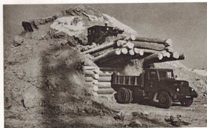
Погрузка камня из отвалов для отсыпки автодороги с Опушки леса к строительной площадке ГРЭС. 1963 год
