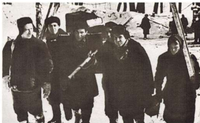
Отряд топографов направляется на топосъемку промплощадки. 1962 год
