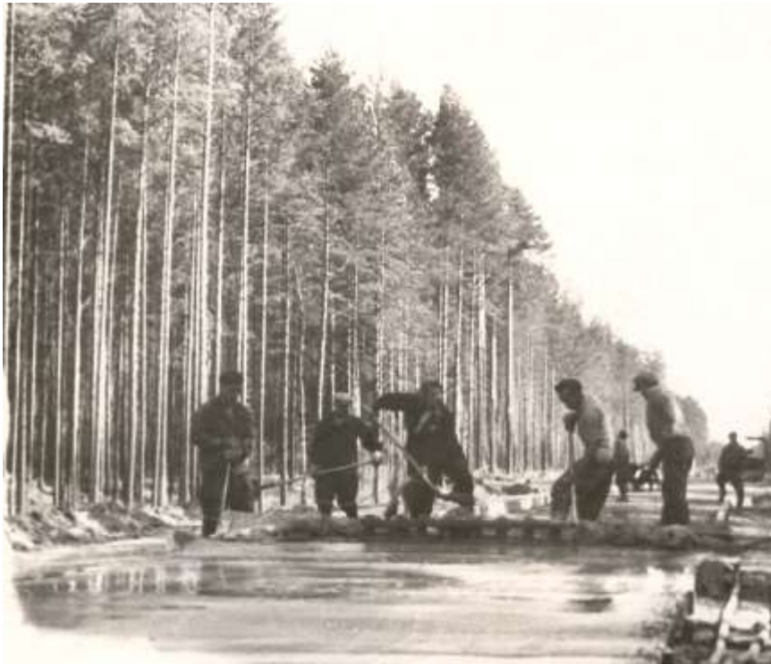
1964 г, заливка полотна дороги. 3-я слева – женщина-бетонщица. Их архива Еловикова Ю.И.
