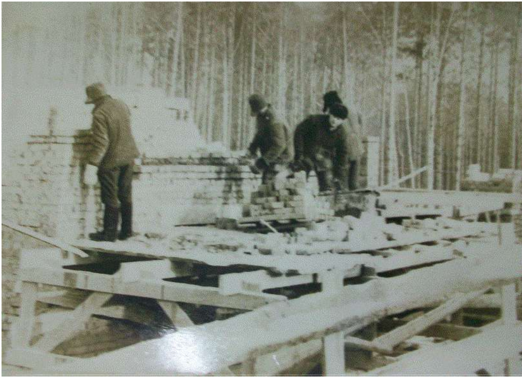
Бригада строителей, 1966 г. Говорухин А.В. во 2-м ряду второй мужчина слева.
