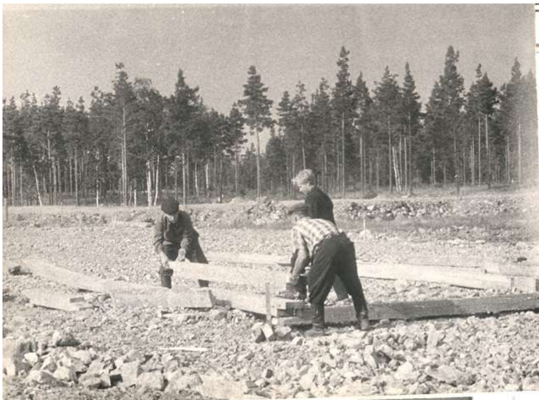
Строительство барака на Опушке
