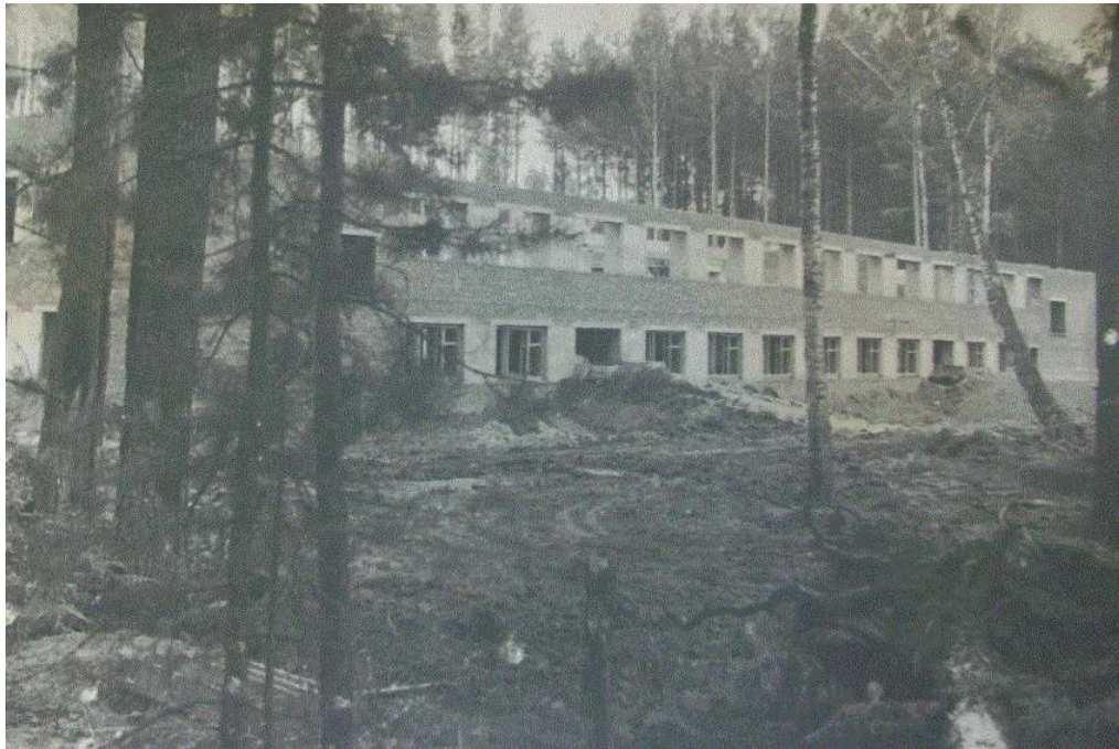
Так выглядела площадка стройбазы в 1966 г.
