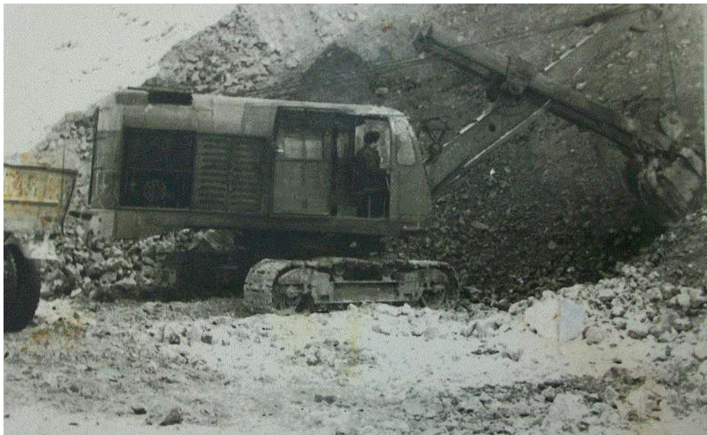
А это уже промышленное строительства. Устройство котлована главного корпуса ГРЭС.
