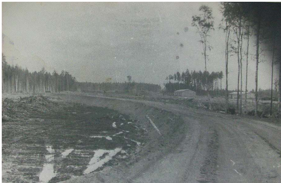
Здесь строится первая рефтинская котельная (на территории, известной под названием автогаража ГРЭС).
